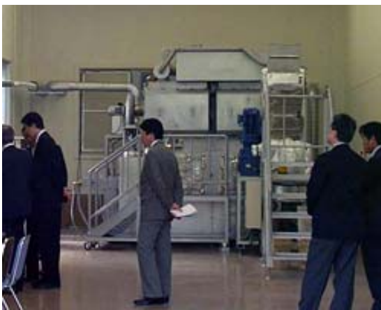
【写真】医療廃棄物燃焼分解処理装置
