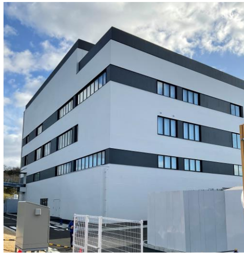
外観状況(北面と東面)
