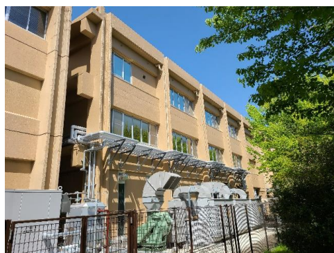
東面外観状況
