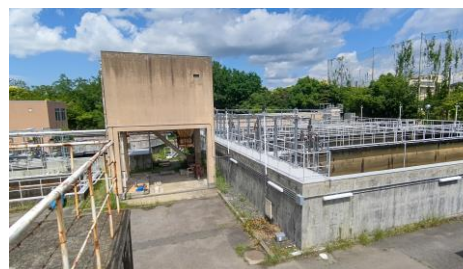
【外観：改修工事後】
