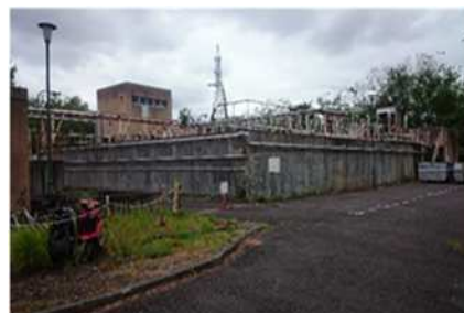
【廃水処理施設 外観】
