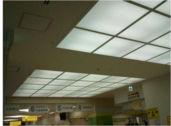
病院に導入した CCFL 照明器具 (CCFL→Cold Cathode Fluorescent Lamp:冷陰極管)
