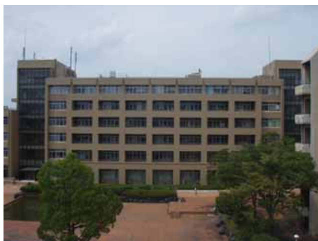
耐震改修が完了した基礎研究棟・一般教養棟
